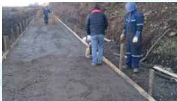
Ejecución de las obras de revestimiento de un tramo del canal.
