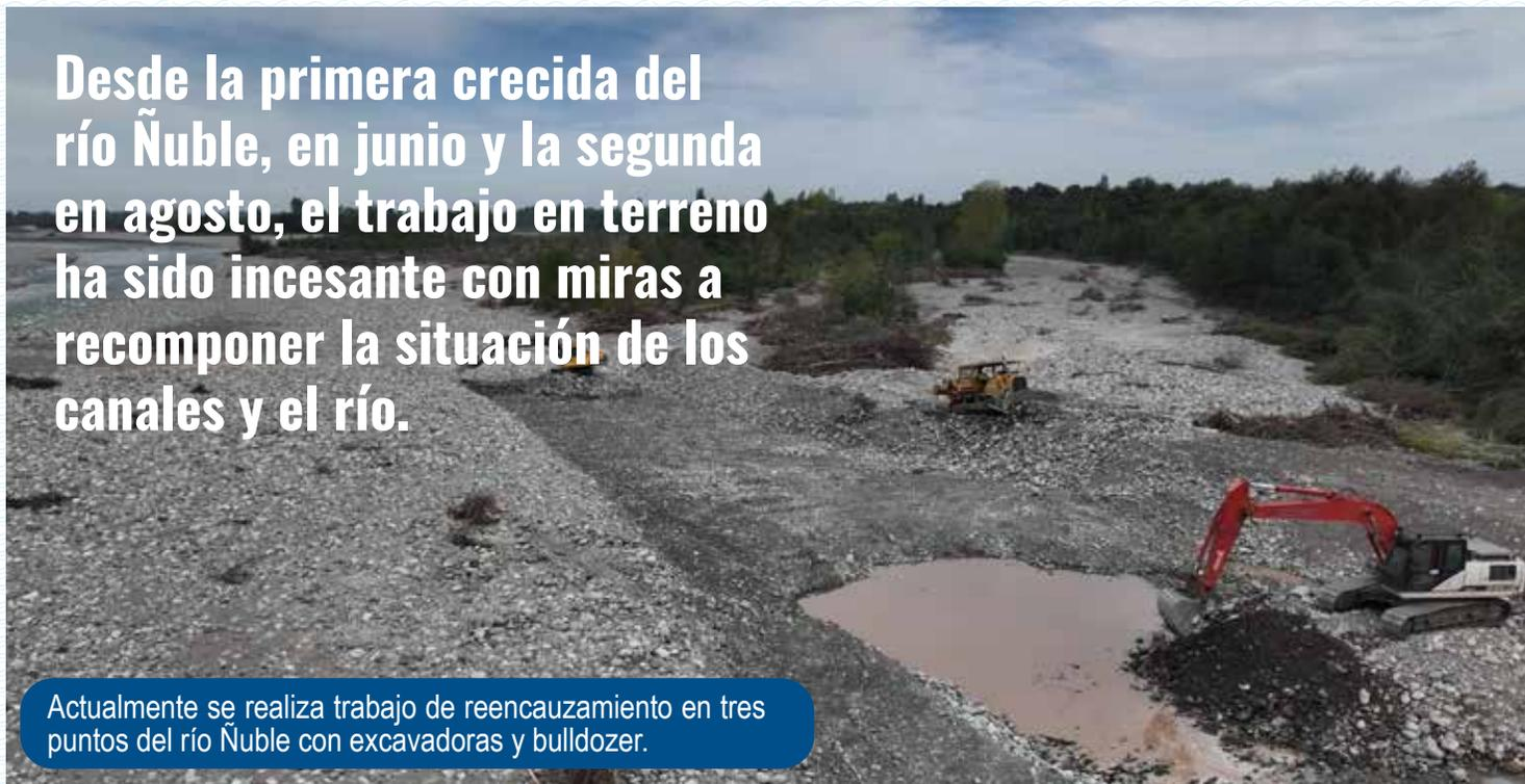
Actualmente se realiza trabajo de reencauzamiento en tres puntos del río Ñuble con excavadoras y bulldozer.
